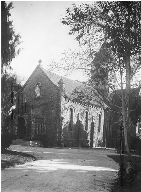
La Capilla en su segunda etapa de construcción. Año 1911
