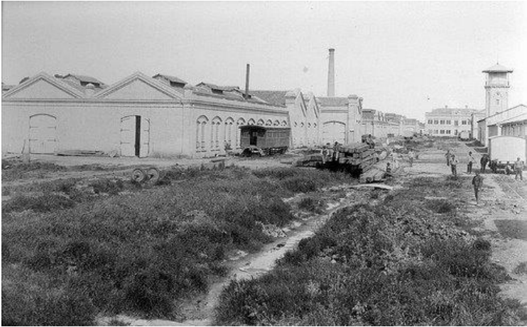
Talleres ferroviarios en Tolosa. Año 1920
